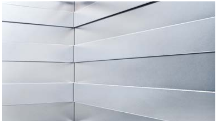
Rammschutzleisten aus gebürstetem Edelstahl
