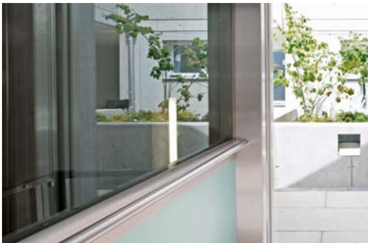
Edelstahl-Handlauf und Kabinenfenster talseitig
